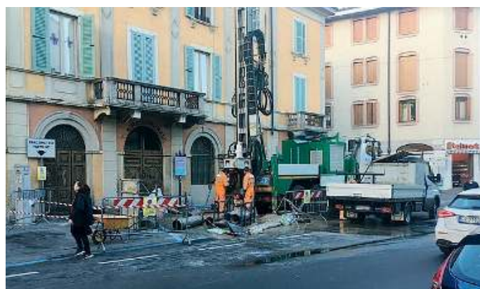
Lavori in corso. L'operazione complessiva costerà 7-8 milioni di euro
